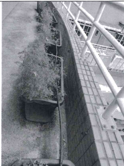
7樓綠植栽區與排水溝渠乾燥無積水
