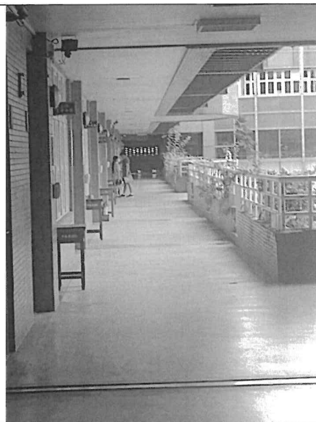
6樓教學區地面乾燥無積水
