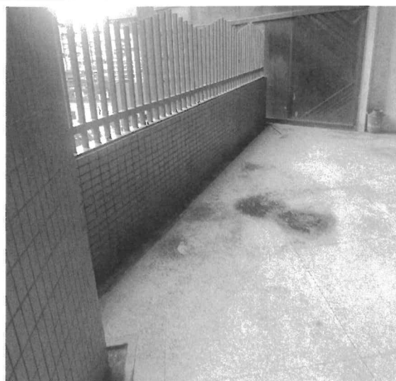
4樓排水溝渠無積水
