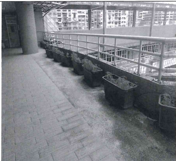
7樓綠植栽區乾燥無積水
