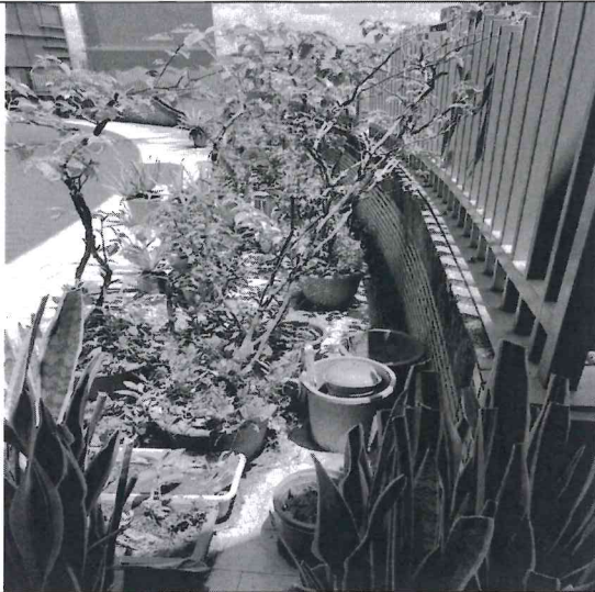
7樓花園區排水溝渠乾燥無積水
