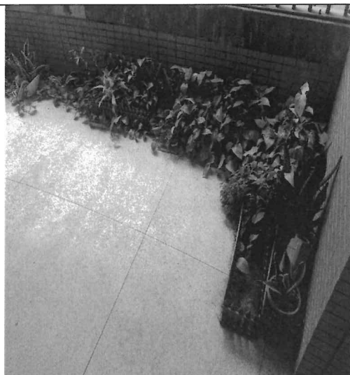
4樓花園區乾燥無積水
