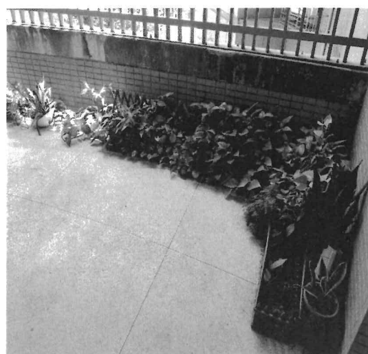
4樓花園區乾燥無積水
