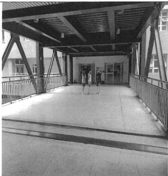
5樓活動中心空橋乾燥無積水
