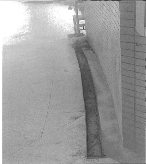
5樓花圃區地面、排水溝渠乾燥無積水
