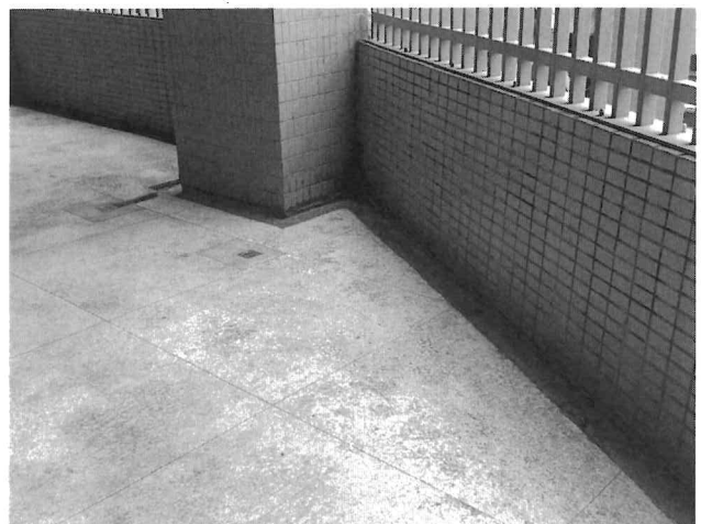
4樓圓心走廊排水區乾燥無積水
