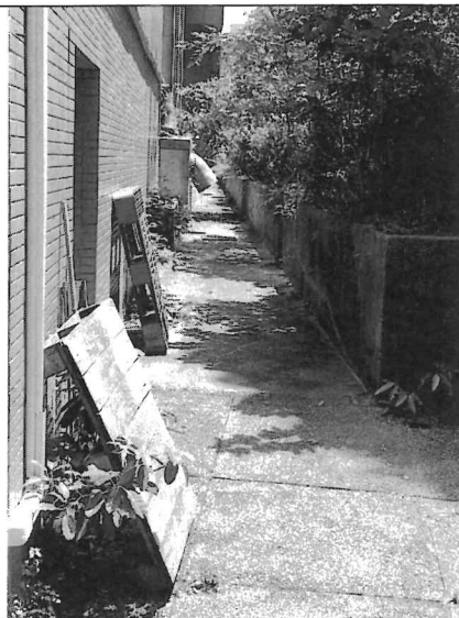
1樓雙電梯前水溝沒積水
