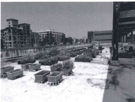
7樓頂樓地面乾爽
