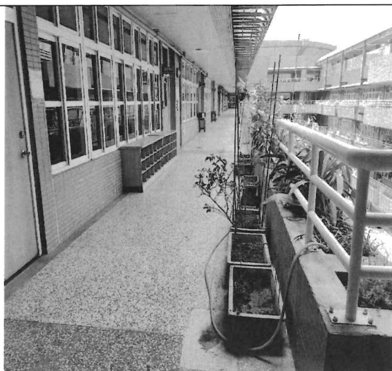
6樓教學區地面、花園乾燥無積水
