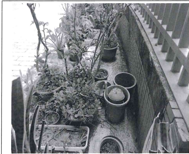
7樓花園區乾燥無積水
