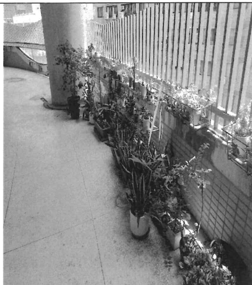
5樓花園區乾燥無積水
