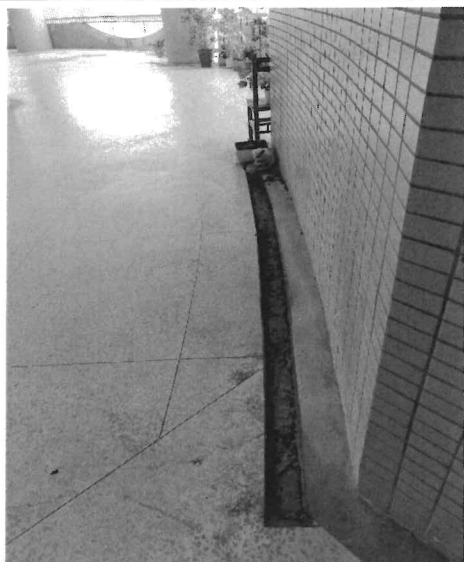
5樓花園區地面、排水溝渠乾燥無積水
