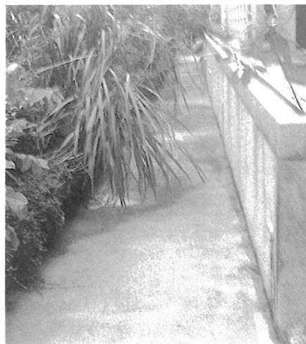
1樓雙電梯前水溝沒積水
