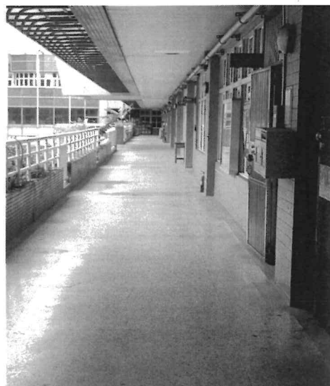
6樓教學區地面、花園乾燥無積水
