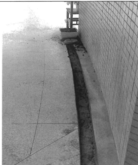
5樓花園區地面、排水溝渠乾燥無積水
