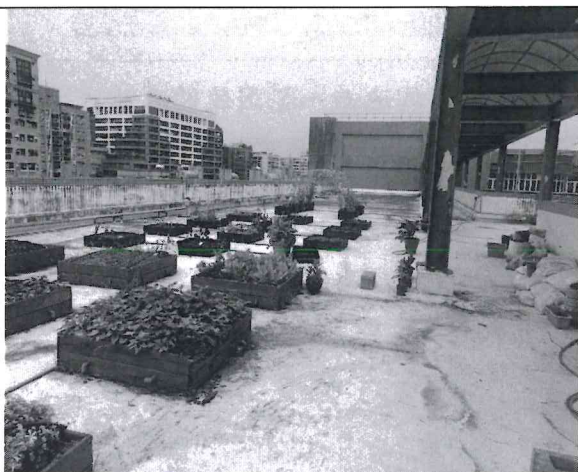
7樓頂樓地面乾爽
