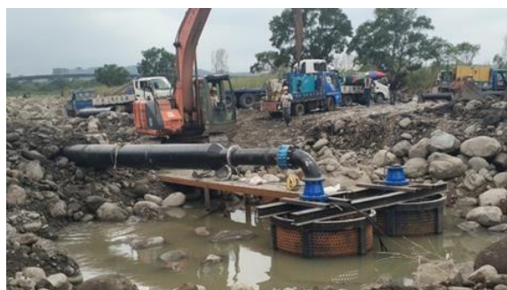
圖 14 油羅溪緊急抽水施工照片
