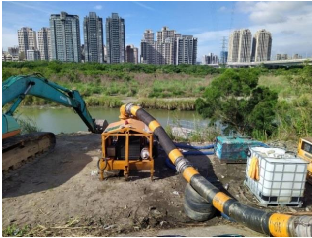
圖 15 隆恩堰下游緊急抽水情形
