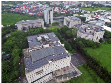
建置屋頂型太陽能發電系統
