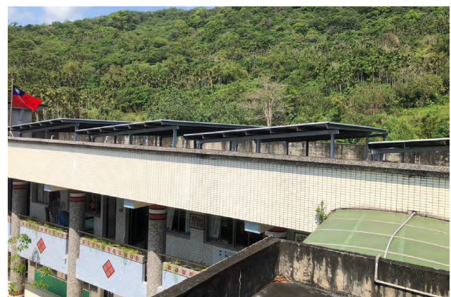
太陽能板並使用 EMS 系統監控管理
