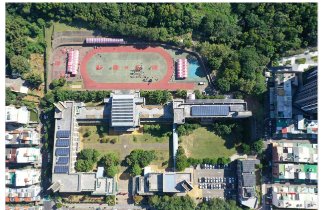
校舍屋頂建置太陽能光電板
