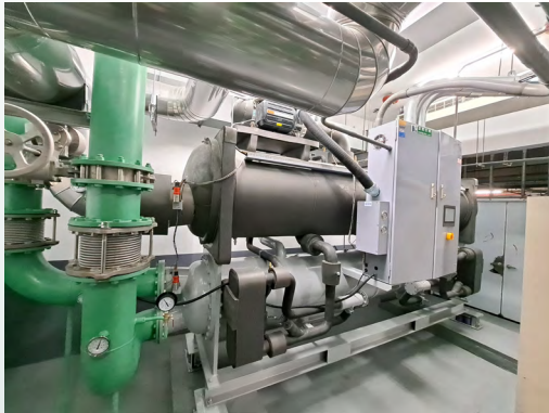
導入人工智慧變頻空調與能源管理 -B1F 主機房 - 打造全國第一台採用全人工智慧變頻控制技術之磁浮離心式及螺旋式空調主機
