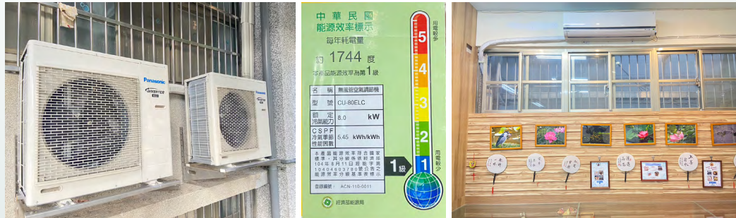
汰換舊式冷氣為變頻冷氣 - 裝設變頻能效一級分級標示冷氣
