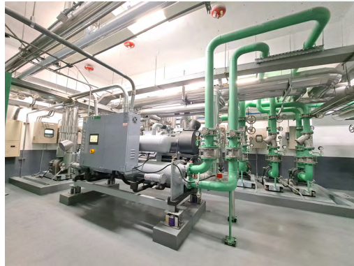
導入人工智慧變頻空調與能源管理 -B1F 主機房 - 打造全國第一台採用全人工智慧變頻控制技術之磁浮離心式及螺旋式空調主機
