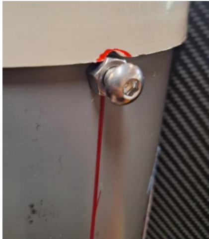
底座使用3支膨脹螺絲固定端點
